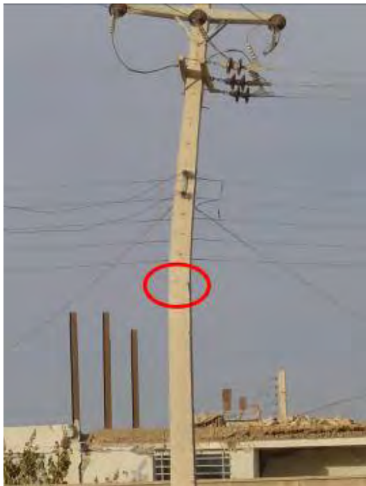
شکل (۳۱-۶): شکست ایجاد شده در تیر برق
