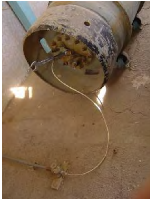
شکل (۳-۶): نمایی از مخزن کلر زنی در حال انجام تعمیرات
