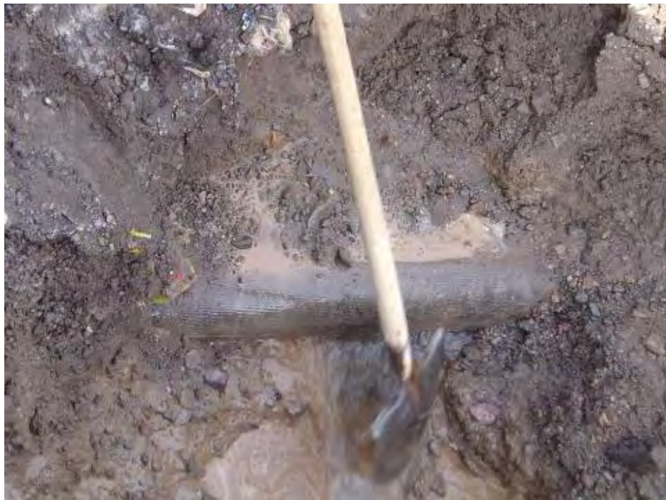
شکل (۵-۶): نشت آب از محل شکست
