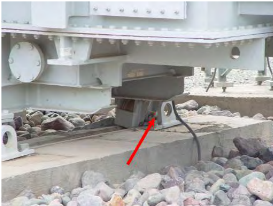
شکل (۶-۱۸): خروج ترانسفورماتور 132 kv از روی ریل
