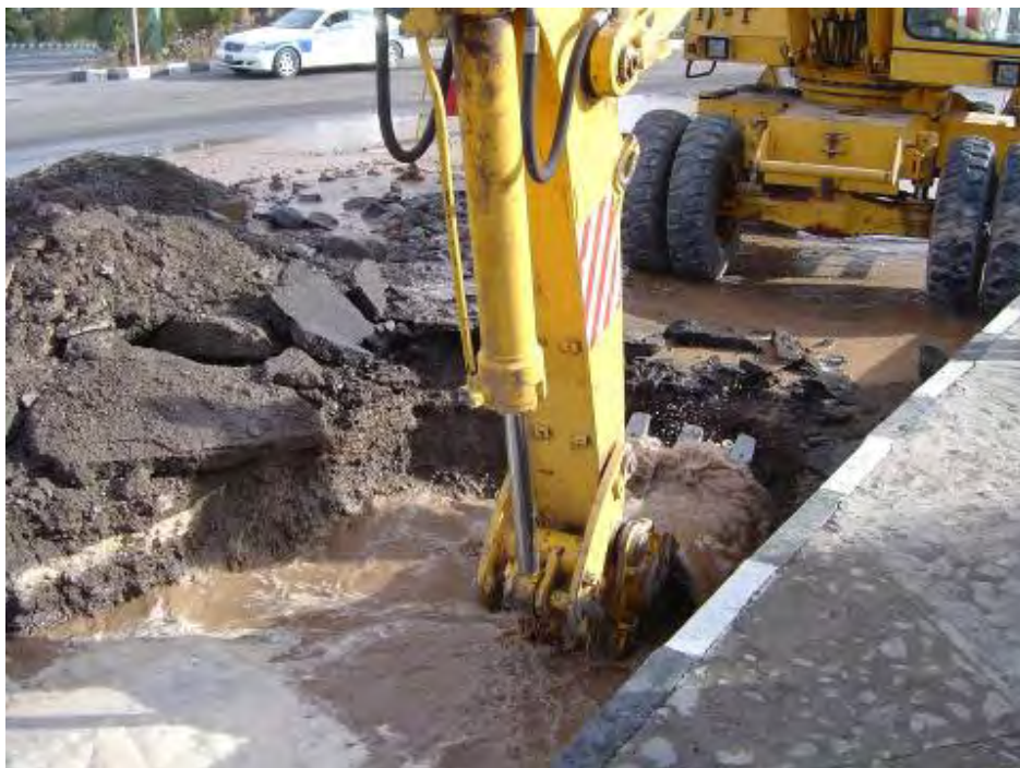
شکل (۴-۶): تخلیه گودال حفر شده در محل شکست لوله و تخلیه آب نشت پیدا کرده با بیل مکانیکی
