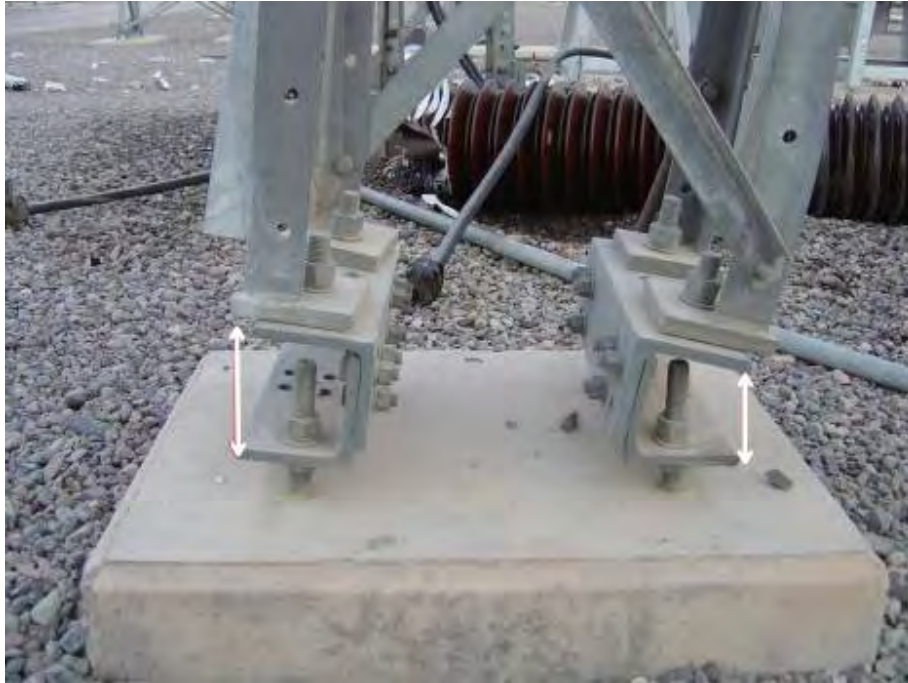
شکل (۶-۲۹): تغییر شکل ماندگار ایجاد شده در ناودانی
