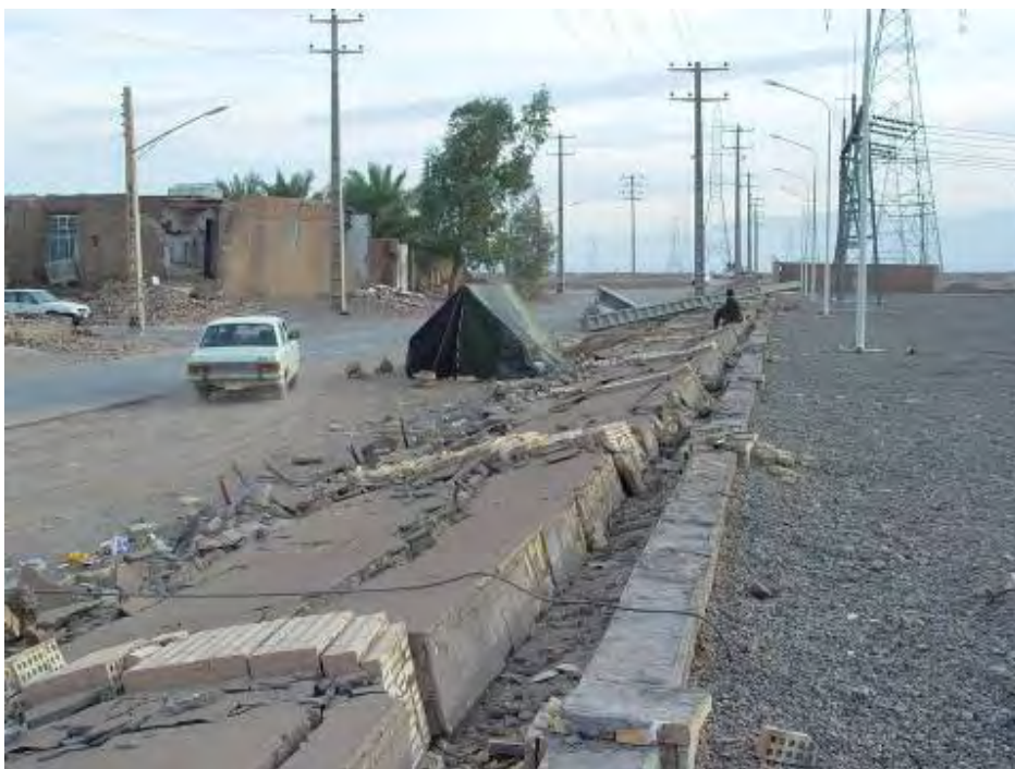
شکل (۶-۱۲): تخریب دیوار نگهبان پست برق به علت عدم وجود لغز در دیوار
