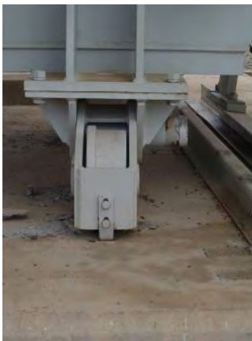
شکل (۶-۲۶): جابجایی ترانسفورماتور از روی ریل
