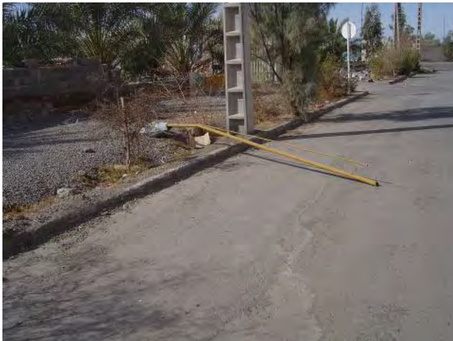
شکل (۳۴-۶): شکست روشنایی متصل به تیر برق
