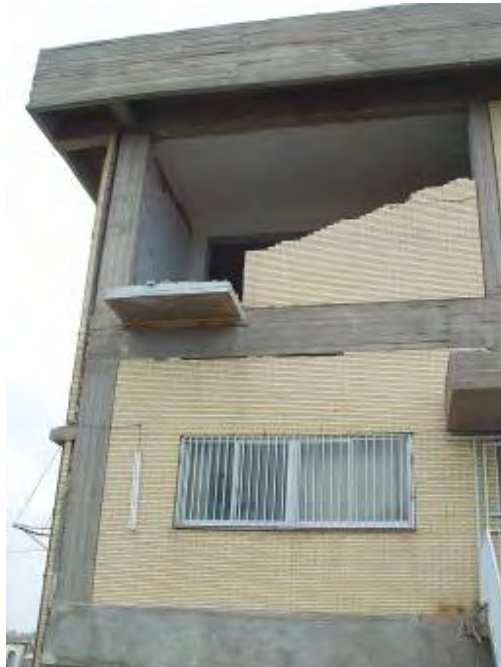
شکل (۶-۳۷): خسارت وارد به میانقابها در ساختمان مخابرات براوات
