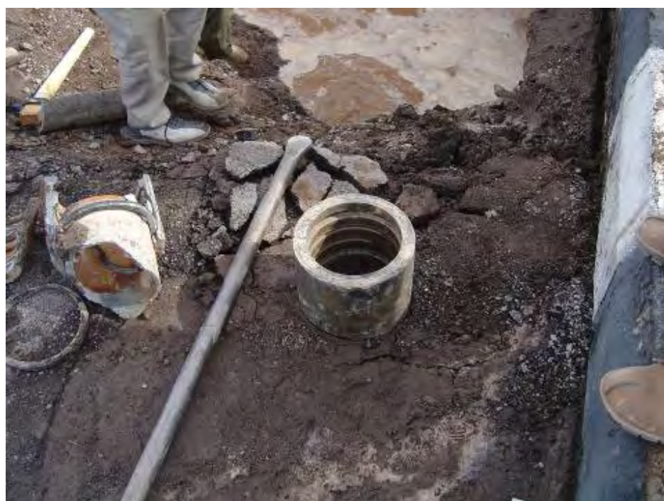
شکل (۶-۶): تعویض اتصالات قدیمی و جدید
